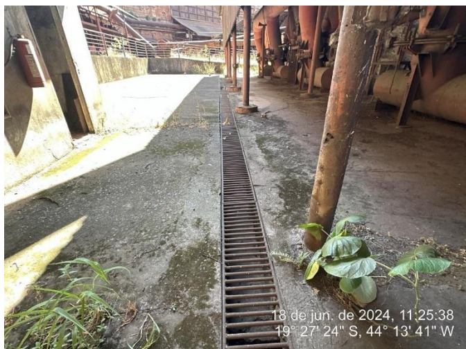
Foto 75: Canaletas do sistema de drenagem no complexo industrial
