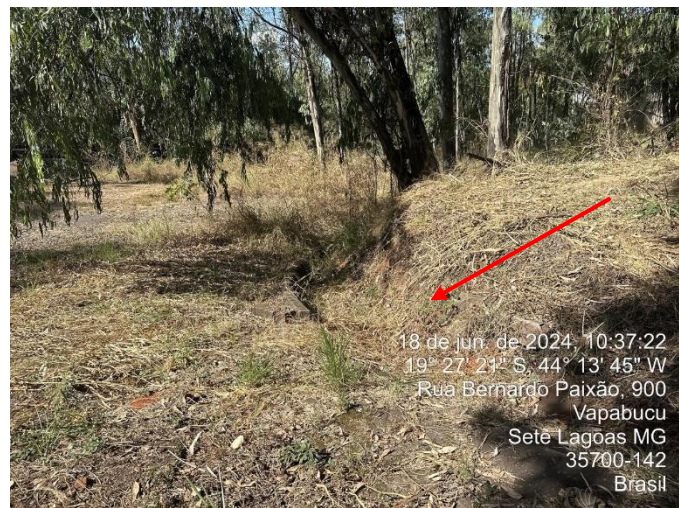
Foto 72: Canaletas do sistema de drenagem próximo ao escritório, com acúmulo de folhas
