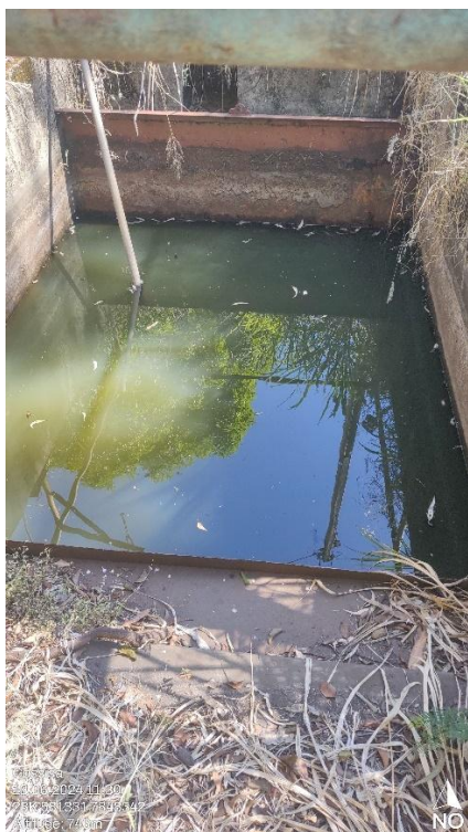
Foto 77: Bacia de decantação que recebe todo o efluente pluvial do empreendimento
