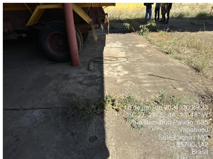
Foto 30: Ausência de canaleta em parte da área destinada à manutenção de veículos
