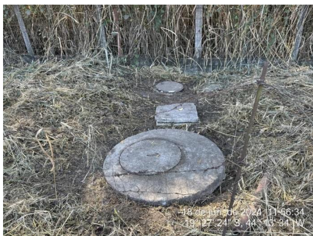
Foto 57: Fossa que recebe efluente do banheiro localizado na oficina mecânica
