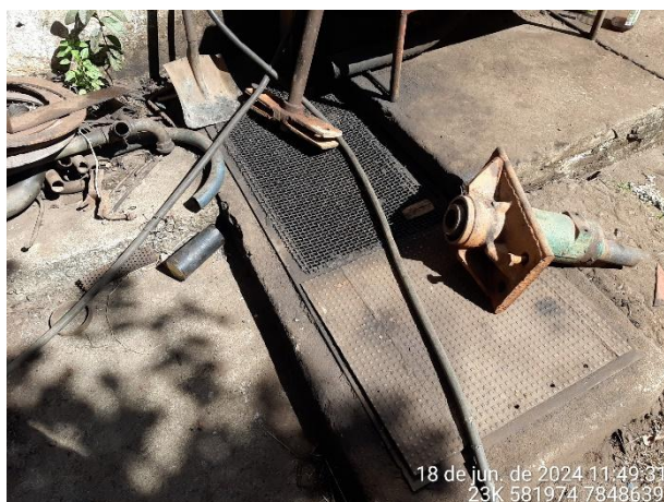
Foto 51: CSAO do tanque de lavagem de peças. É possível verificar indícios de extravasamento de efluente para fora da área de lavagem e escorrendo para dentro da caixa.
