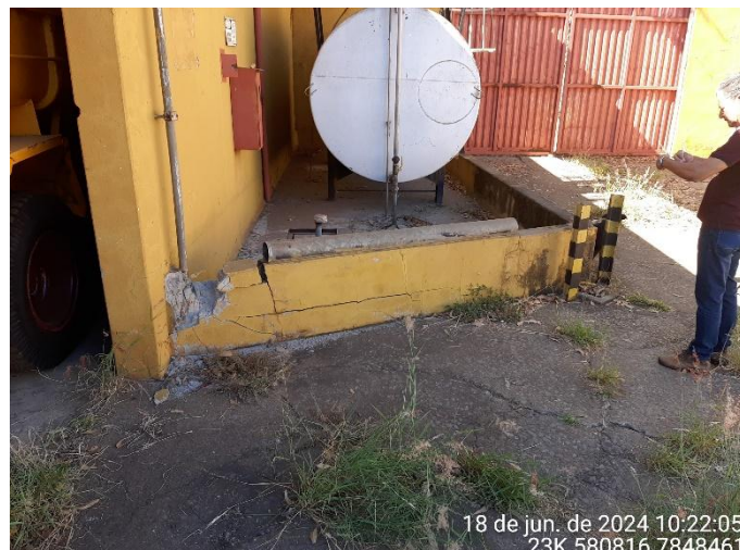
Foto 40: Bacia de contenção do tanque de combustível com parte da estrutura quebrada. A frente na foto a pista de abastecimento.
