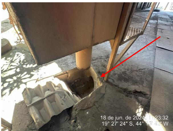
Foto 67: Parte do sistema que direciona lama do lavador de gases
