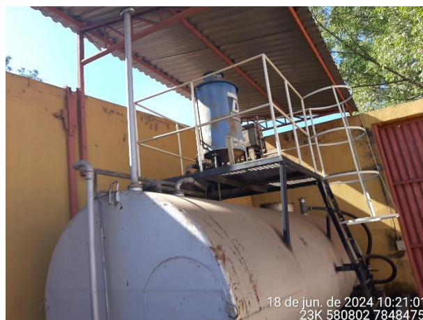
Foto 42: Bomba de combustível instalada acima do tanque. Já o marcador eletrônico de medição fica instalado no piso, dentro da bacia de contenção.
