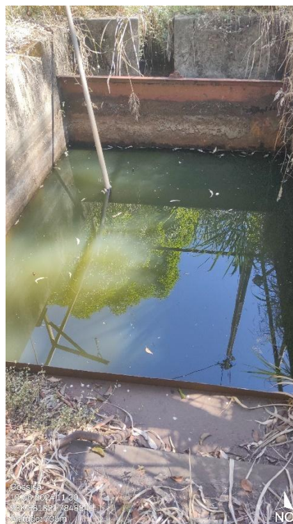
Foto 78: Bacia de decantação que recebe todo o efluente pluvial do empreendimento
