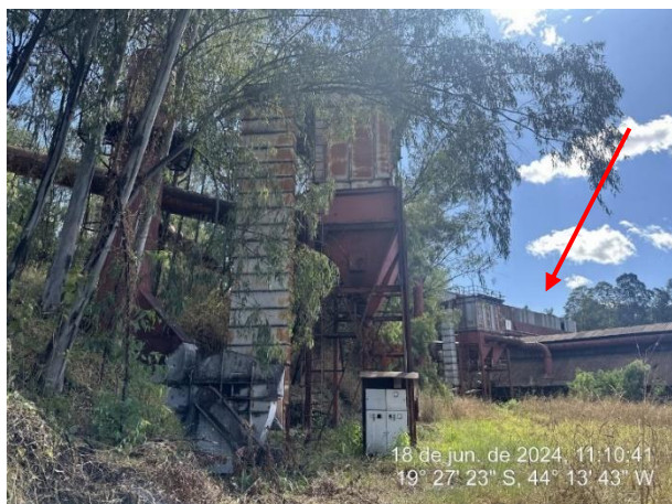
Foto 13: Filtro de mangas que contempla sistema de descarga de carvão e também do sistema de peneiramento do carvão do alto-forno 02, e indicado por seta ao fundo está o mesmo sistema, mas do alto-forno 01
