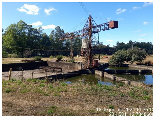
Foto 68: Estrutura que recebe a lama do lavador para ser decantada, e posteriormente separado líquido dos sólidos
