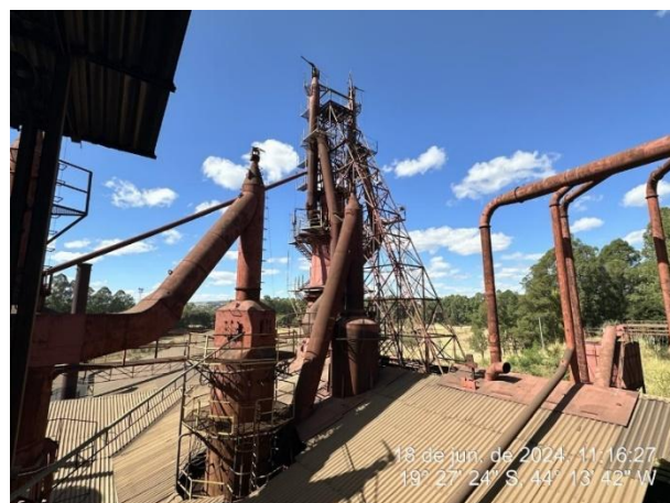
Foto 14: Vista da parte de cima da estrutura, evidenciando parte do sistema dos exaustores do complexo do alto-forno
