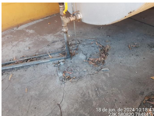
Foto 41: Piso da bacia de contenção apresenta porção quebrada e com trincas.
