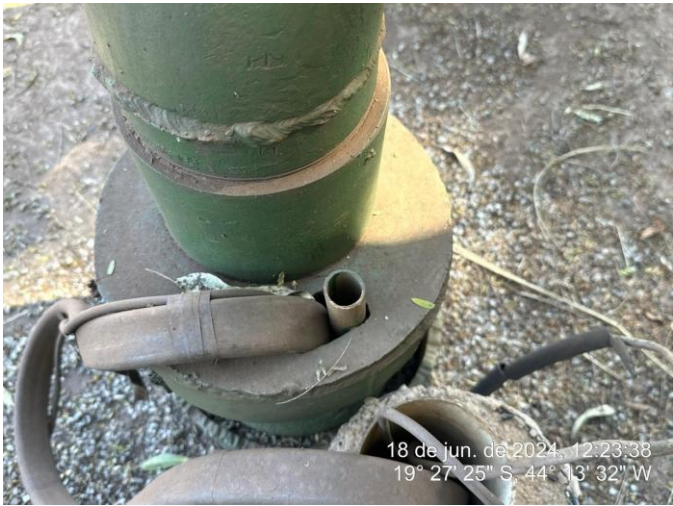
Foto 85: Entrada do tubo guia, sem tampa
