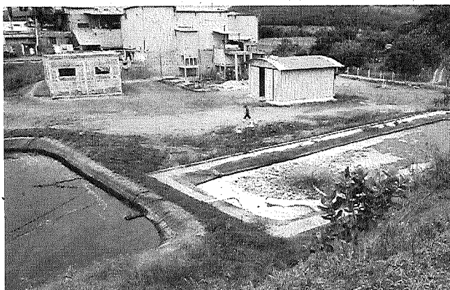
Foto 03. Estação de Tratamento de Efluentes - ETE
