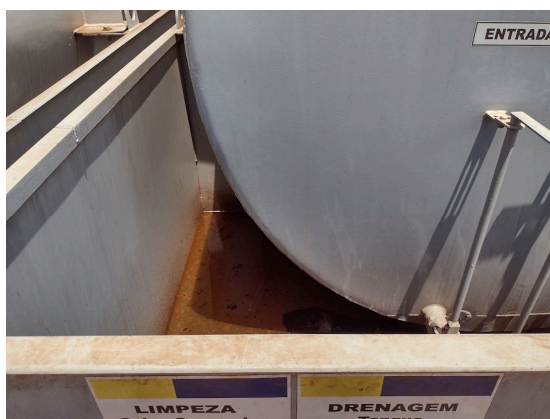
Foto vistoria 02: Tanque com bacia de contenção
