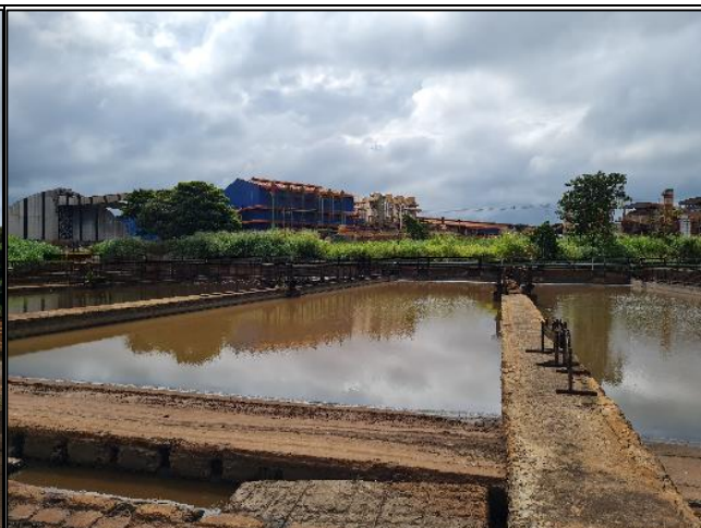
Tanques de decantação. Fonte: Coruripe 2021
