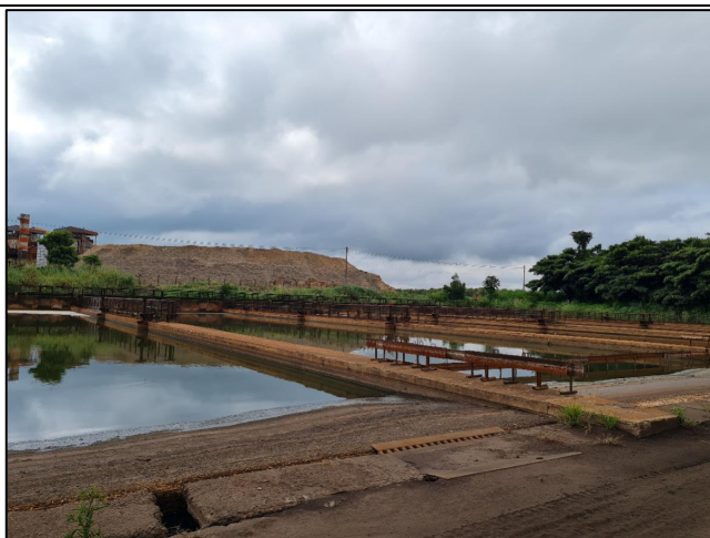
Tanques de decantação. Fonte: Coruripe, 2021
