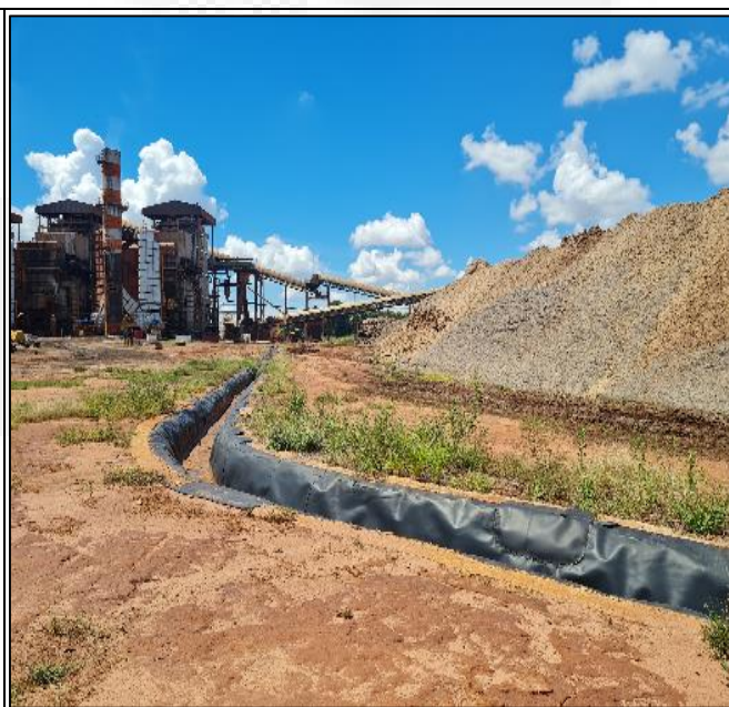
Canaletas impermeabilizadas com PEAD.
