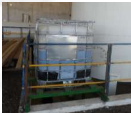
Foto 02. Contentor e tanque de solução sobre bacia de contenção.
