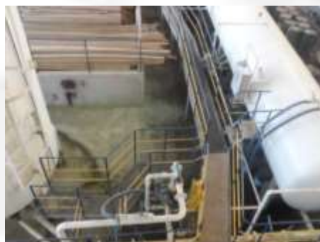
Foto 04. Vista geral da bacia de contenção sob autoclave e tanque de solução.
