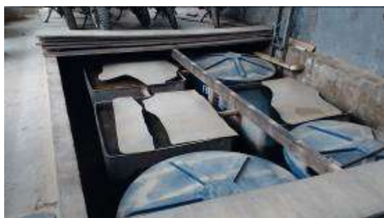
Figura 3: Caixas Separadoras de água e óleo
