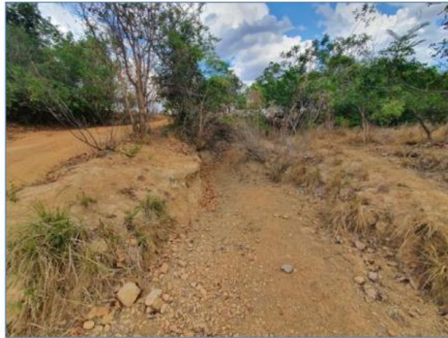
Figura 3-5 Solo erodido próximo ao Córrego Buriti
