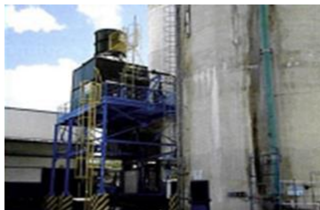
Foto 10 - Detalhe da ETA p/ reaproveitamento da água de condensados.
