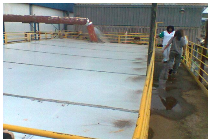
Foto 06 - Detalhe tanque equalização enclausurado com coleta de gás e envio p/ queima na caldeira
