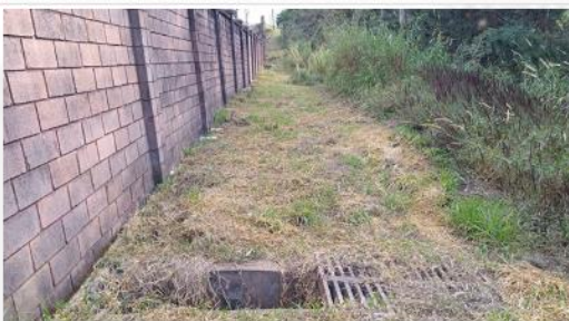
Dispositivo de drenagem da BR-356 no terreno do Lagoa da Serra
