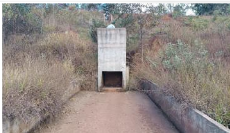
Figura 5: Demonstração do fluxo superficial e da localização Dispositivo de drenagem da BR-356.
