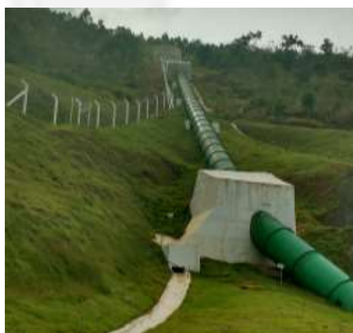
Foto 03. Conduto forçado e chaminé de equilíbrio.
