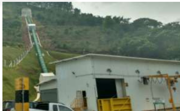
Foto 02. Vista da Casa de Força, do conduto forçado e chaminé de equilíbrio.
