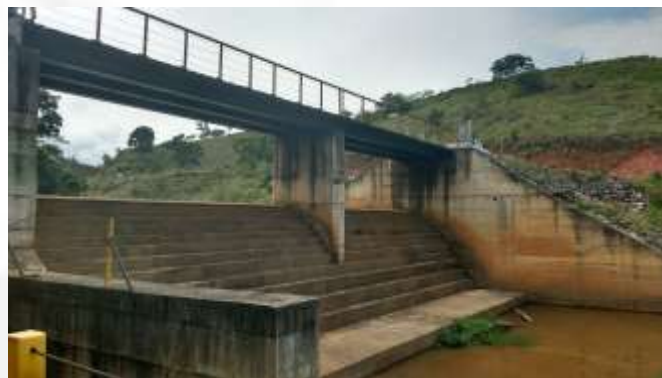
Foto 06: Vista do vertedouro central do tipo soleira livre.
