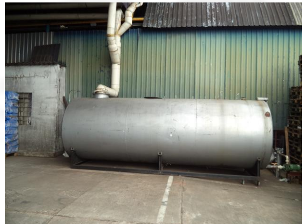
Foto 08. Tanque de água de chuva
