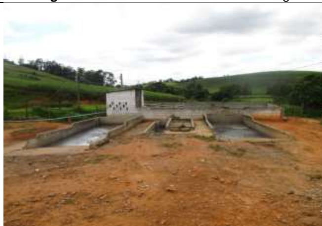
Figura 8: Sistema separador de efluentes sólidos e líquidos.
