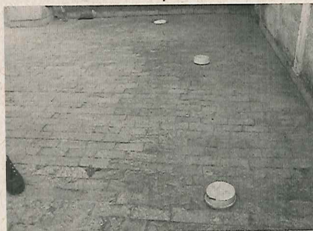
Foto 08. ETE (filtro anaeróbico e Sumidouro)
