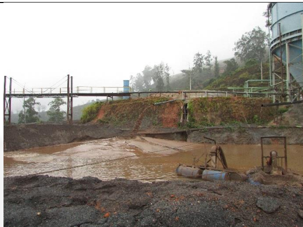
Fotografia 02: Baía existente na área da UTM.
