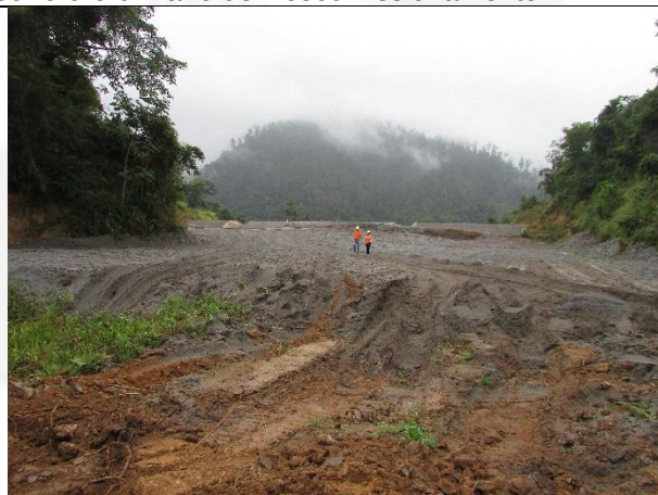
Fotografia 06: Rejeitos acumulados sobre o antigo reservatório da Barragem (atual Pilha da Voçoroca).
