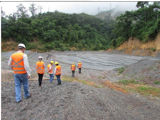
Fotografia 05: Rejeitos acumulados sobre o antigo reservatório da Barragem (atual Pilha da Voçoroca).
