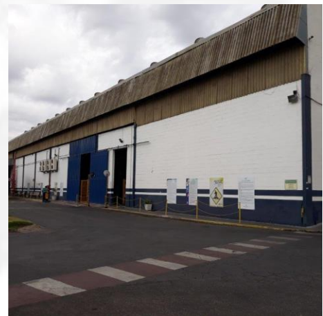
Foto 04. Acessos na Marelli e vista de um dos galpões.
