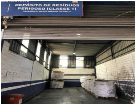
Foto 01. Depósito de resíduos perigosos sólidos/líquidos
