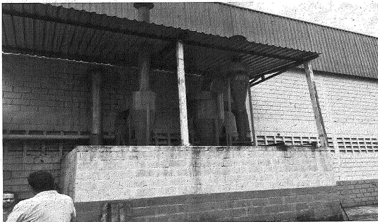
Foto V – Ciclone de exaustão do setor de “escariação” (lixamento) da borracha dos pneus.
