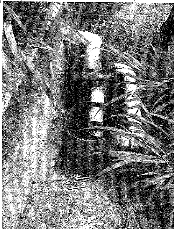
Foto V – Ciclone de exaustão do setor de “escariação” (lixamento) da borracha dos pneus.
