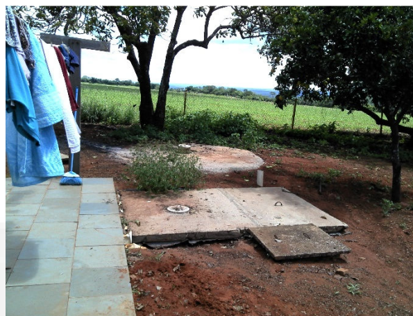
Figura 14. Fossa séptica seguida de sumidouro
