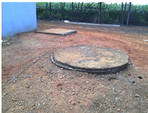
Figura 13. Fossa séptica seguida de sumidouro
