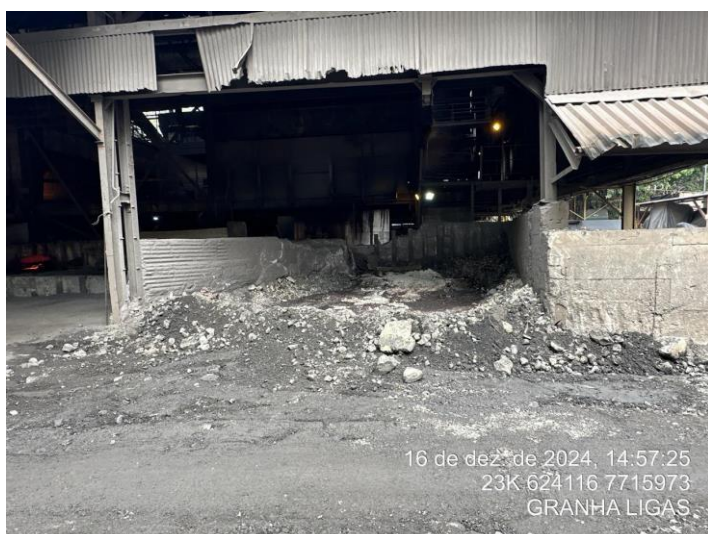
Foto 33: Local onde a escória se acumula após escoar pela ala de corrida.
