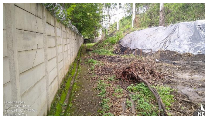
Foto 58: Outra canaleta que compõe sistema de drenagem superficial da linha férrea, localizada próxima ao muro da Granha Ligas. Ela é direcionada para dentro do empreendimento.
