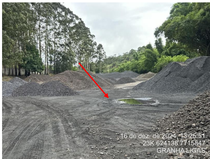
Foto 50: Pontos de acumulação de efluentes superficiais no pátio de matéria-prima.
