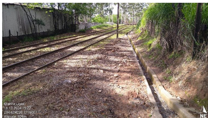
Foto 57: Canaleta que compõe sistema de drenagem superficial da linha férrea. A mesma é direcionada para dentro do empreendimento.
