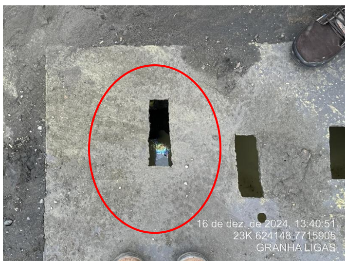
Foto 53: Possível observar óleo sobrenadante nos efluentes que se encontravam dentro de uma das caixas de passagem do empreendimento.
