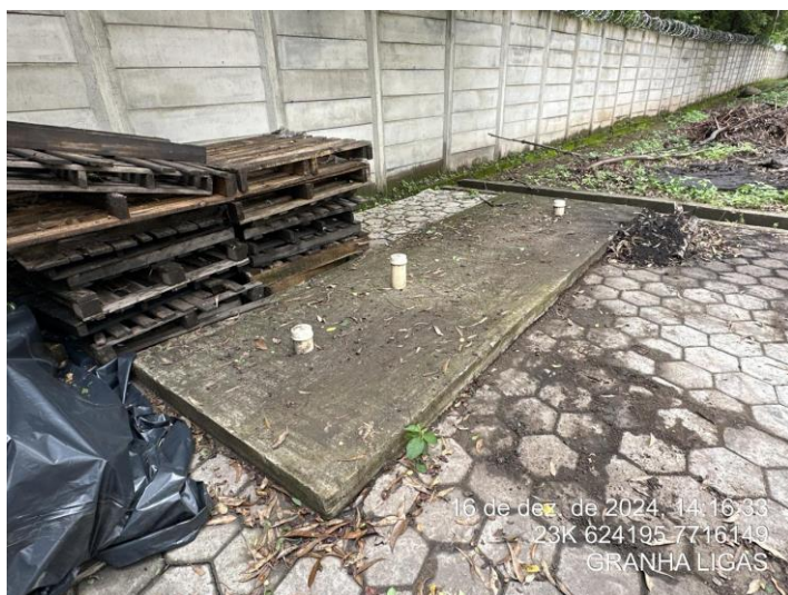
Foto 35: Fossa do empreendimento.
