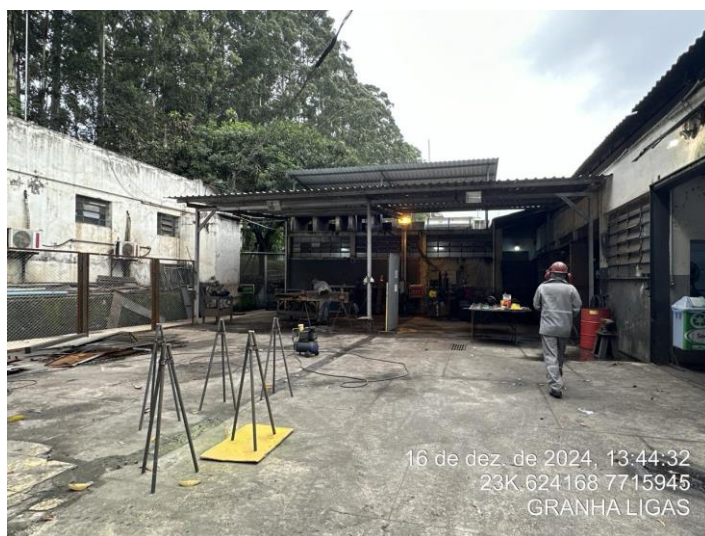
Foto 42: Vista do galpão da oficina industrial
