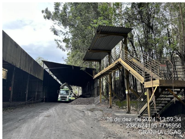
Foto 4: Galpão de descarregamento de carvão vegetal.
