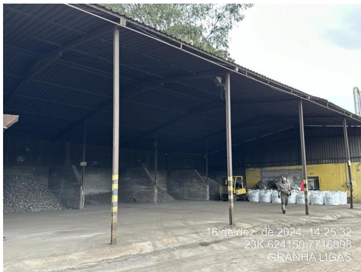
Foto 21: Galpão de armazenamento do produto final, já beneficiado.
