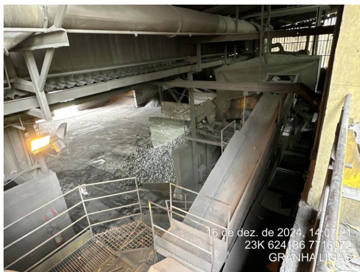
Foto 18: Vista da planta da britagem.
