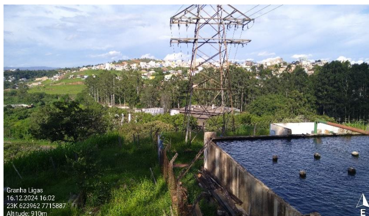
Foto 2: Linha de Transmissão que compõe sistema de rede elétrica do empreendimento. Abaixo dessa LT há uma caixa d'água que armazena a água para o empreendimento ( backup ).
