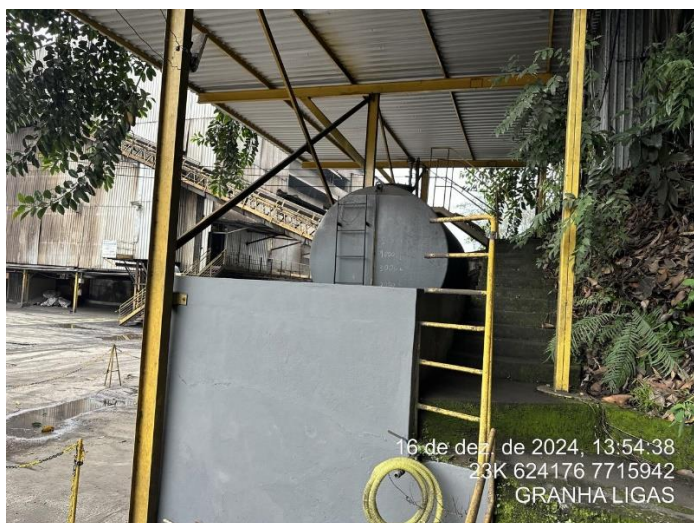
Foto 47: Vista do tanque de diesel.
