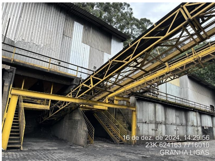
Foto 7: Correas transportadoras as quais direcionam o carvão e demais matérias-primas para os fornos.
