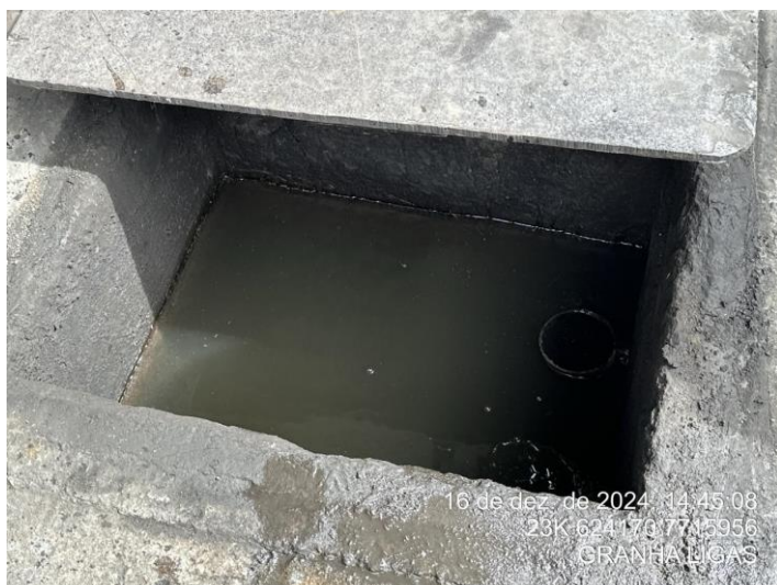
Foto 39: Saída da CSAO associada ao posto de combustíveis.
