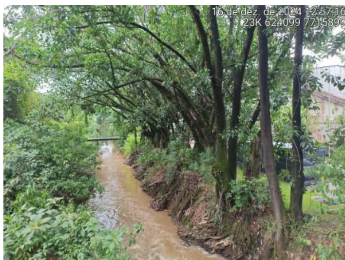
Foto 65: Interseção do Ribeirão Bananeiras com a área diretamente afetada (ADA) do empreendimento – visão geral.
