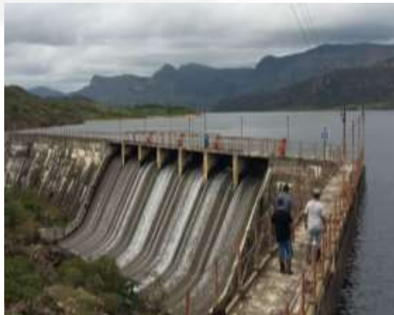
Figura 02: vertedouro Fonte: PCA/RCA, 2015
