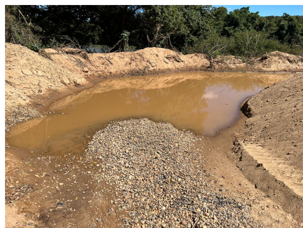
Foto 04. Bacia de contenção de sólidos finos escoados da pilha de areia oriunda da dragagem.
