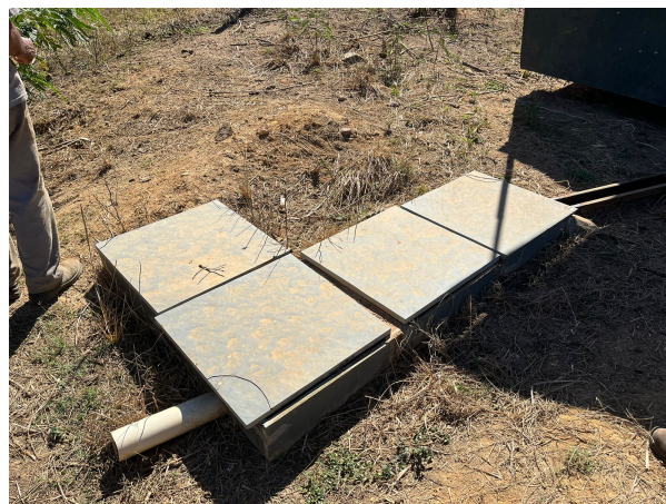
Foto 06. Caixa SAO instalada junto ao ponto de abastecimento.
