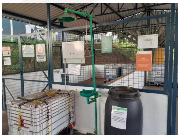
Depósito de químicos
