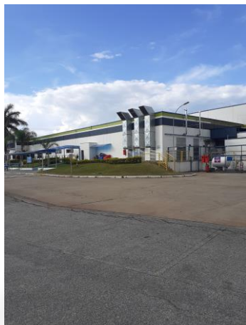
Vista geral da fábrica
