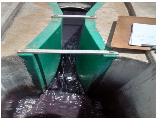
Fig. 09 – Entrada para o decantador terciário
