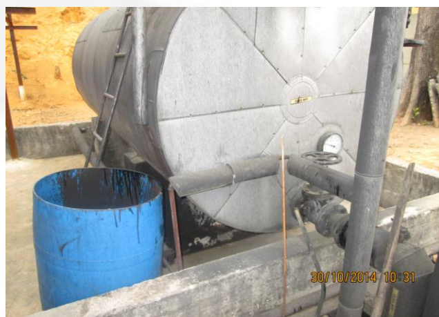
Fig. 22 – Tanque de óleo em bacia de contenção.
