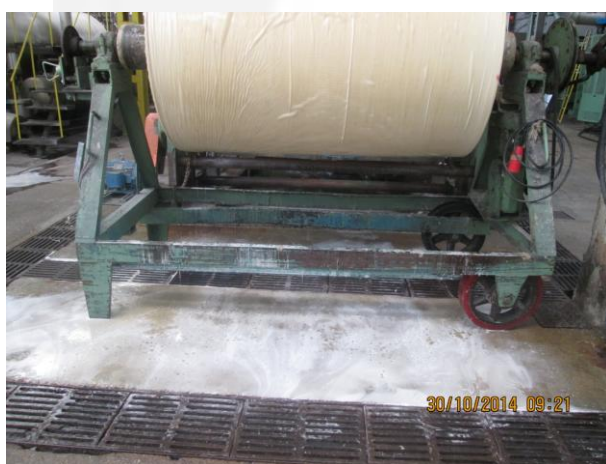
Fig. 17 – Canaletas para condução dos efluentes industriais.
