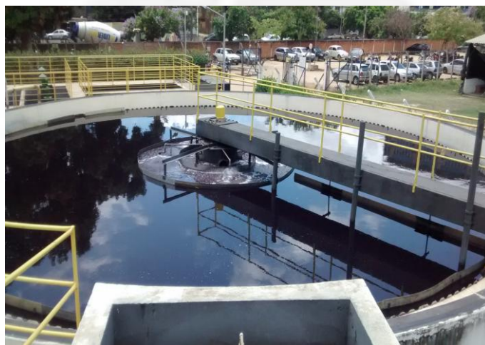
Fig. 08 – Decantador Secundário
