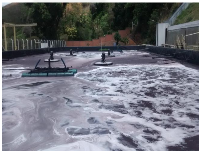
Fig. 07 – Tanque de Aeração
