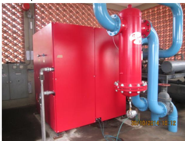
Fig. 02 – Filtro utilizado para separação do óleo da descarga dos compressores.
