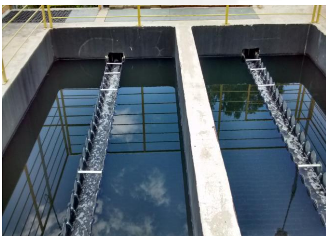
Fig. 11 – Término do processo de floculação e decantação.
