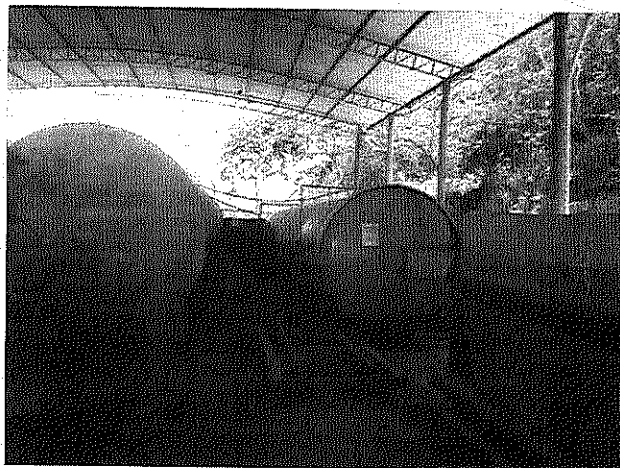
Foto 02 – À direita, encontra-se a autoclave e, ao lado desta, tanque de diluição do produto químico em água.
