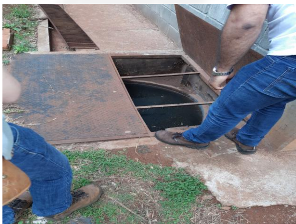
Foto 05. Caixa de contenção de efluentes industriais
