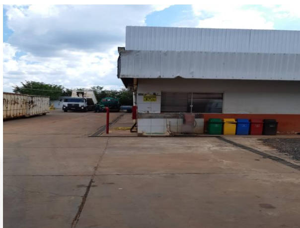
Foto 04. Pátio de movimentação de veículos com canaletas para captação de efluentes
