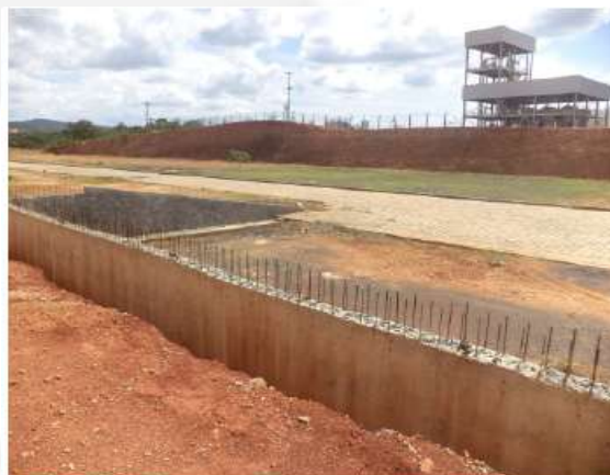
Foto 16 – Muro de arrimo das docas
