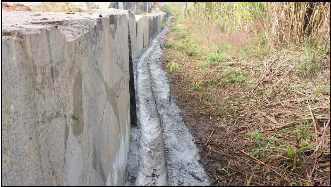
Figura 15 – Canaletas de drenagem na base da pilha.
