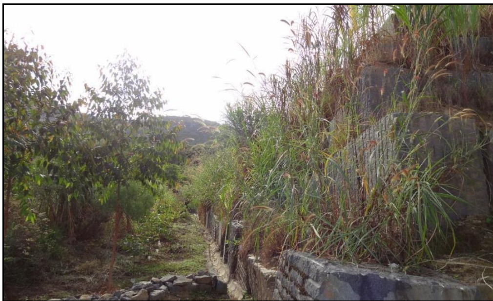
Figura 14 – Vista dos blocos de contenção com presença de vegetação entre eles.
