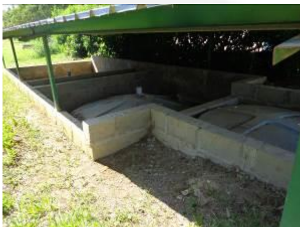
Foto 09. Sistema Fossa-Filtro-Sumidouro
