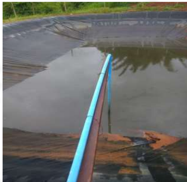
Foto 02: lagoa Anaeróbica
