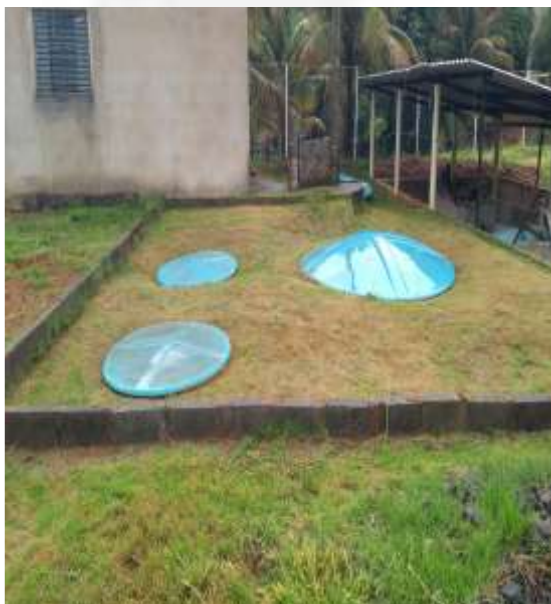
Foto 01: tanques sépticos da ETE Industrial
