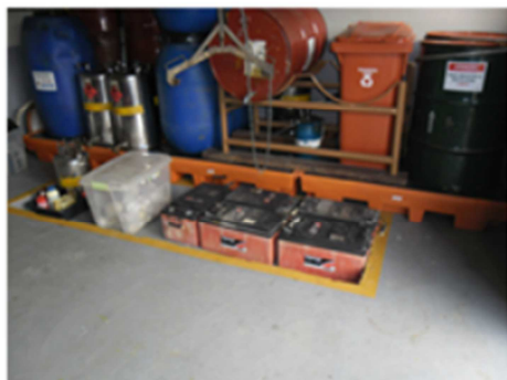
Locais de armazenamento de resíduos dotados de bacia de contenção
