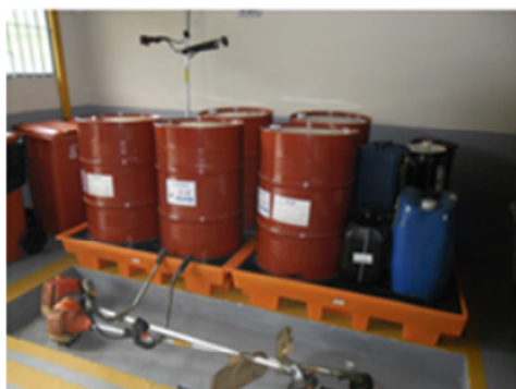
Depósito de Oleos e Graxas Com bacia de Contenção
