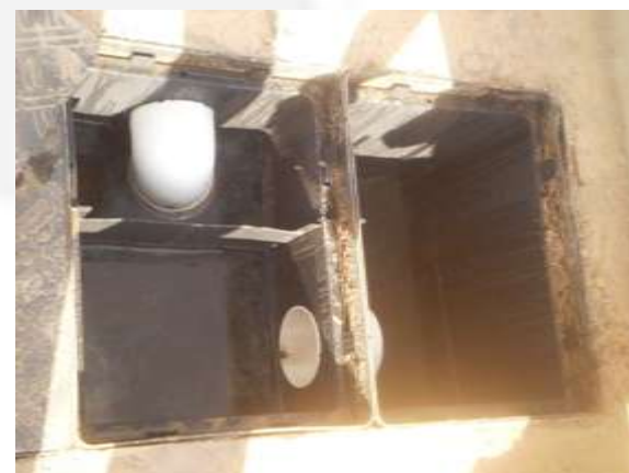
Foto 10- Caixa Separadora de Água-Óleo da unidade de abastecimento..
