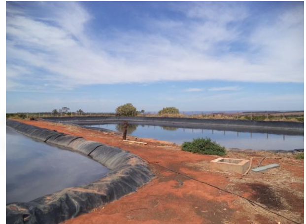
Foto 02. Lagoa de estabilização
