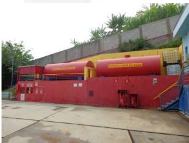
Foto 05. Reservatórios de água para combate a incêndio.
