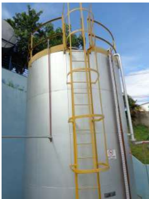
Foto 03. Tanque de Armazenamento Aéreo Vertical.
