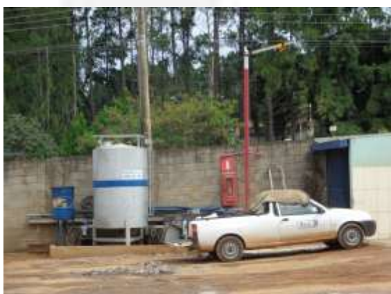
Foto 09. Tanque de restos de combustível em bacia de contenção ligada a caixa SAO.
