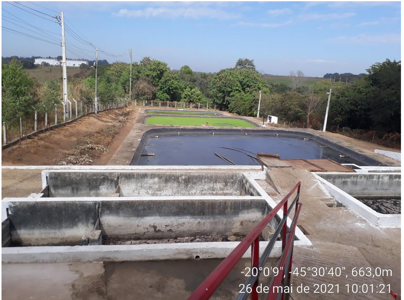
Foto 03: Estação de Tratamento de Efluentes.
