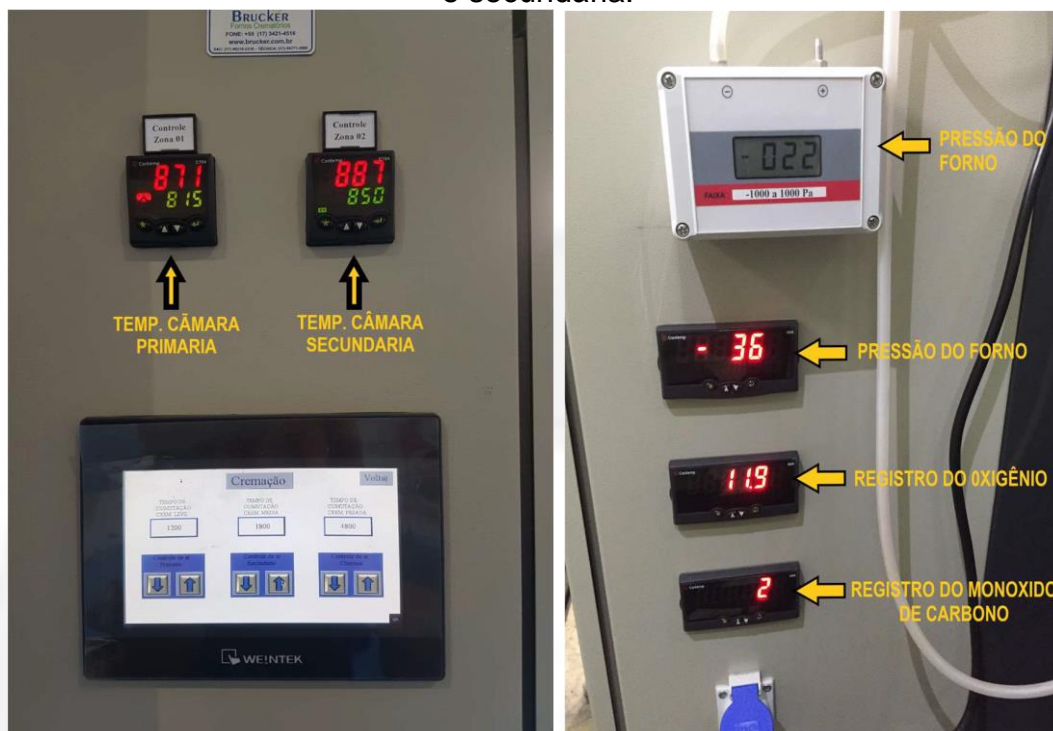
Figura 4 – Registradores dos fornos de cremação com indicação das câmaras primária e secundária.
