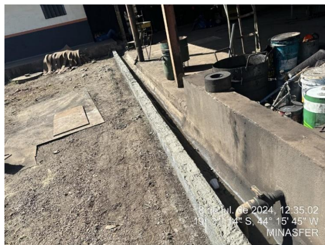
Foto 30: Reparo sendo realizado em canaleta da oficina industrial (toda a parte lateral com a estrutura de cimento mais clara)
