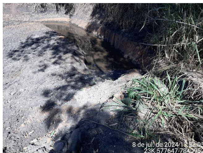
Foto 32: Detalhe da chegada dos efluentes na bacia de decantação.
