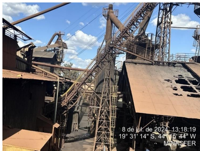
Foto 6: Detalhe do telhado do alto-forno 04 com avarias
