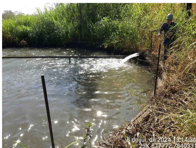
Foto 21: Evidência de ausência de estruturas de proteção dos tanques de armazenamento e resfriamento da água de processo.
