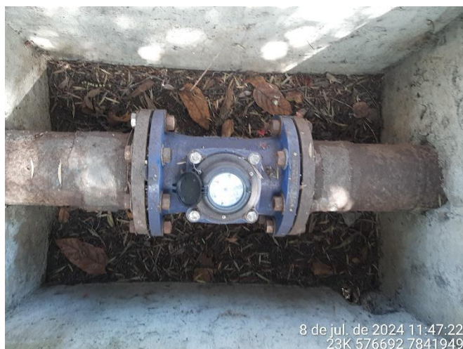
Foto 111: Hidrômetro da captação superficial.
