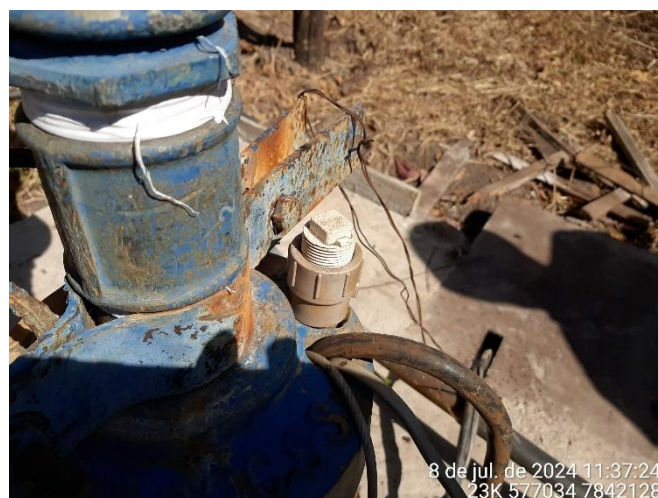
Foto 106: Tubo de monitoramento estático do poço tubular subterrâneo.
