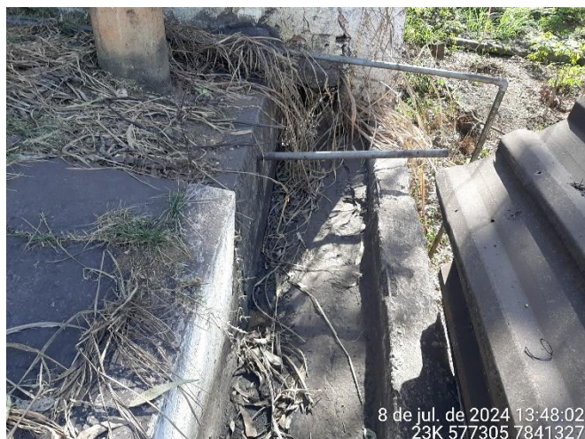
Foto 41 Canaleta por onde o efluente proveniente da área operacional é direcionado para a primeira caixa de passagem da tubulação subterrânea municipal.
