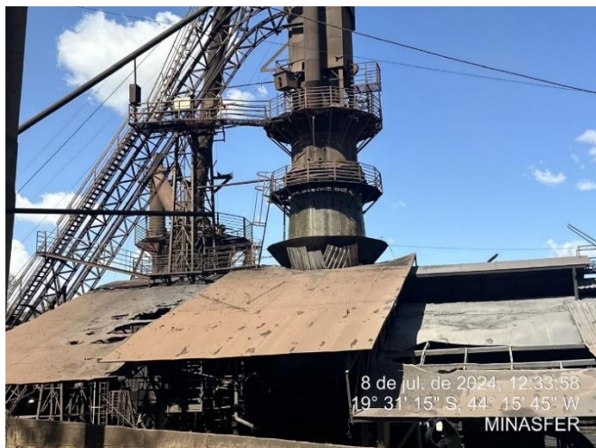
Foto 5: Telhado do alto-forno 04 com avarias
