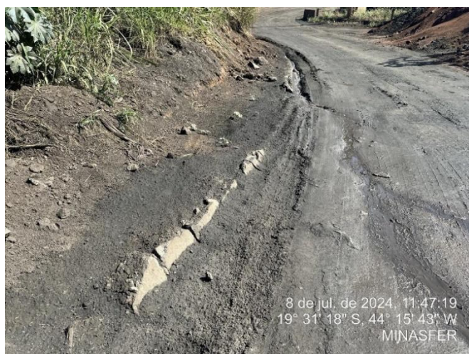
Foto 25: Canaleta de drenagem na via de acesso à bacia de decantação, necessitando de limpeza e reforma nas suas estruturas
