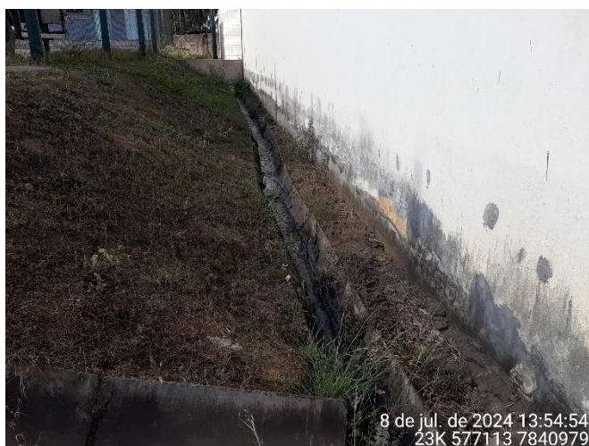
Foto 39 Canaleta que recolhe efluente do posto.
