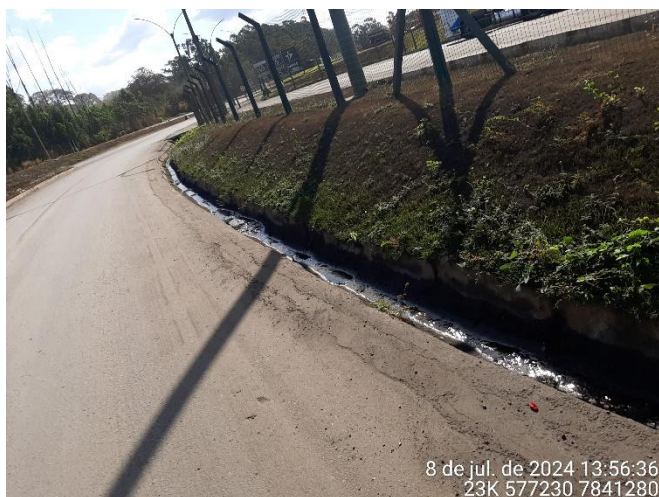
Foto 37: Canaleta recebendo efluente do posto e água pluvial da marginal da BR040.
