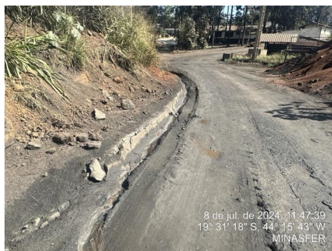
Foto 26: Canaleta de drenagem na via de acesso à bacia de decantação, necessitando de limpeza e reforma nas suas estruturas
