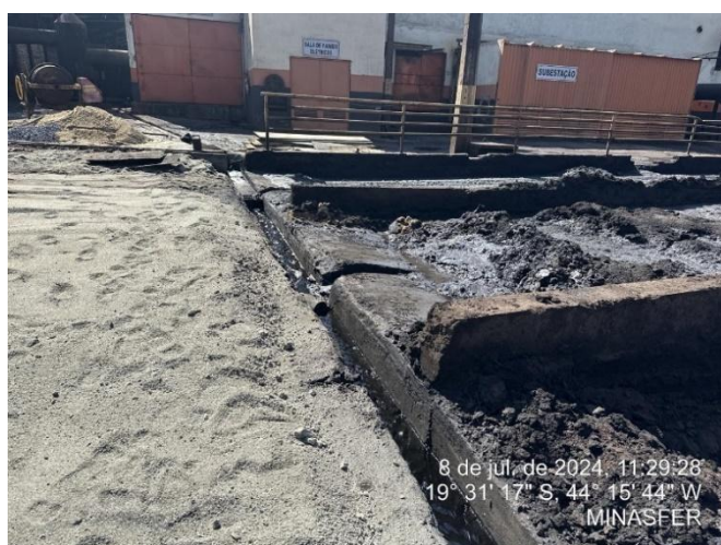
Foto 45: Sistema do direcionamento dos efluentes advindos do lavador de gás
