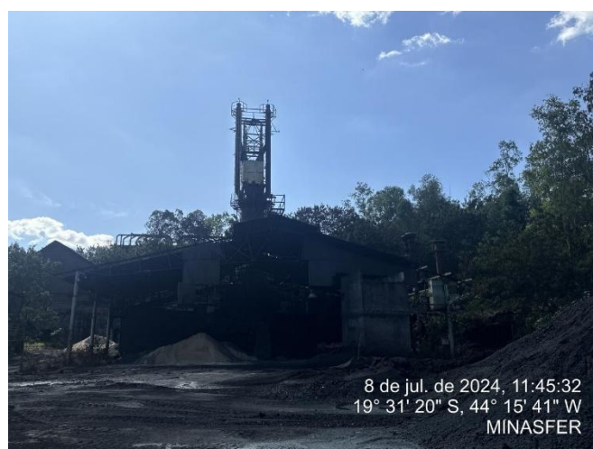
Foto 4: Estrutura do alto-forno – alto-forno 01, que se encontra desativado
