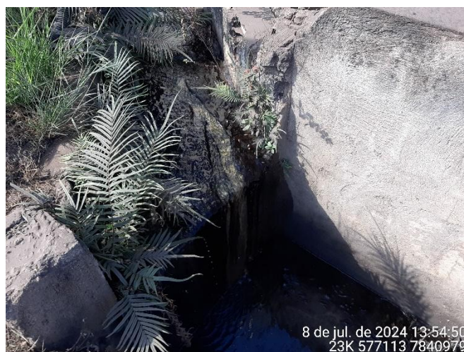
Foto 40: Caixa de passagem que recebe o efluente da canaleta que coleta o efluente do posto integrada à tubulação subterrânea municipal
