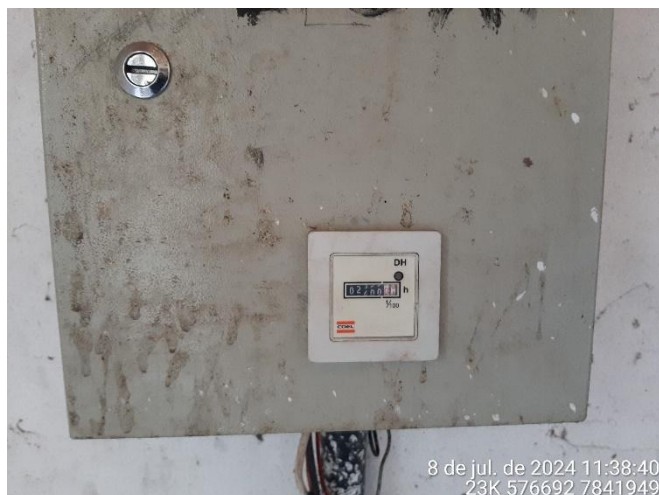
Foto 107: Horímetro do poço tubular subterrâneo.
