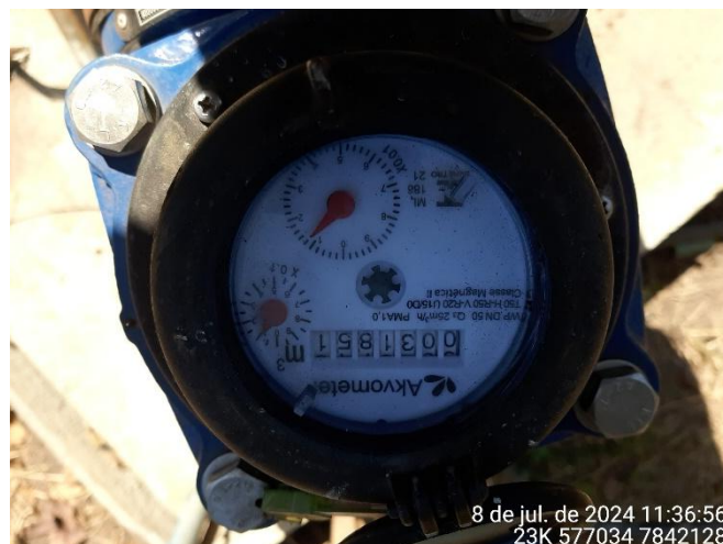
Foto 104: Hidrômetro do poço tubular subterrâneo.
