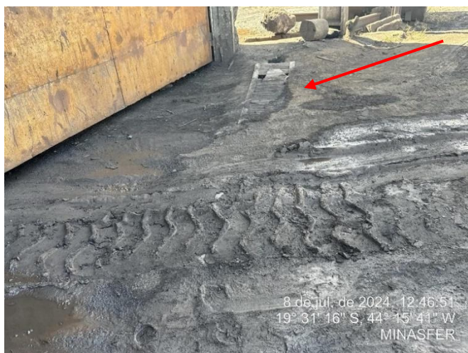
Foto 15: Canaleta de drenagem na entrada do galpão de carvão, com acúmulo de material
