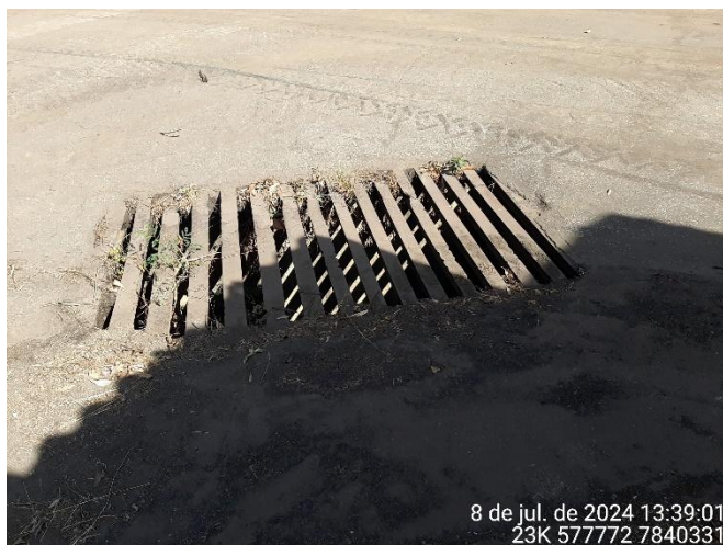
Foto 35: Grade sob a caixa de passagem da tubulação subterrânea municipal localizada próxima ao ponto de abastecimento.
