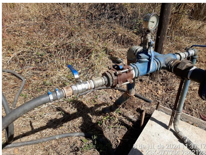
Foto 105: Torneira de monitoramento do poço tubular subterrâneo.
