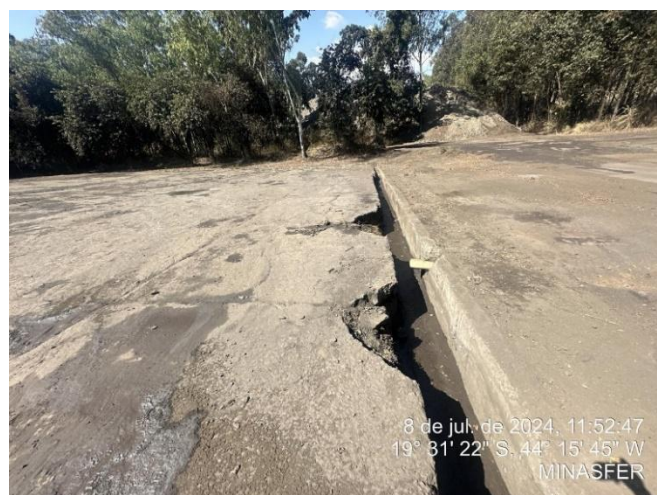
Foto 28: Canaleta de drenagem no pátio onde os lingotes são depositados, necessitando de reparo
