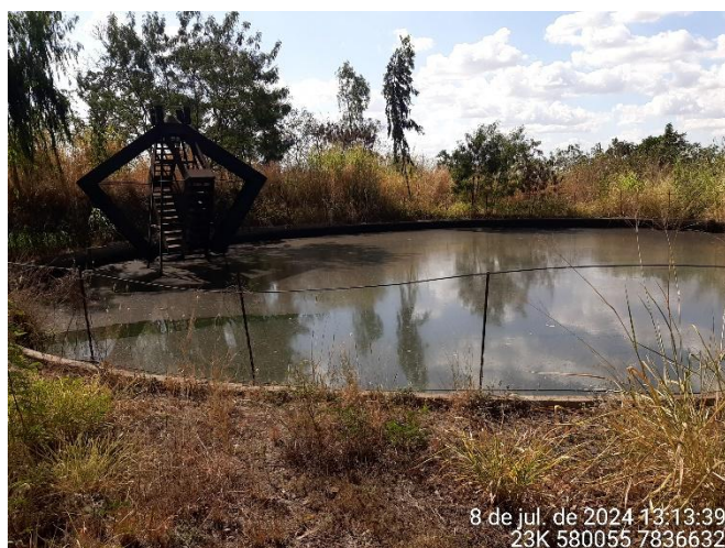
Foto 19: Tanque maior de armazenamento e resfriamento de água de processo.
