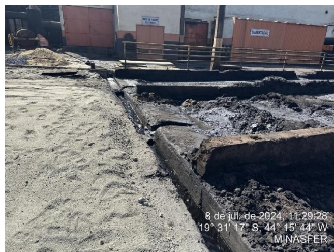
Foto 48: Tanque de pó de balão, evidenciando canaletas que advêm do lavador de gases
