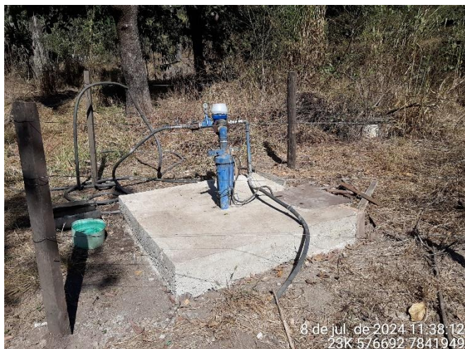
Foto 103: Poço tubular subterrâneo isolado com cerca de arame liso, dotado de laje de concreto.
