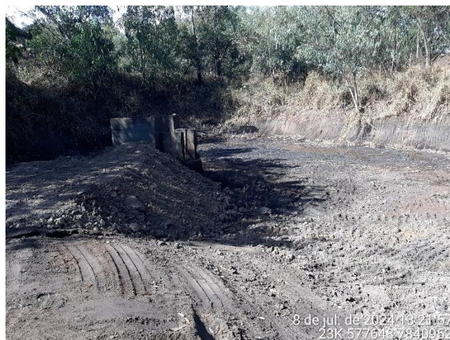
Foto 36: Caixa de passagem da tubulação subterrânea municipal que funciona como vertedouro da bacia de decantação da Minasfer.
