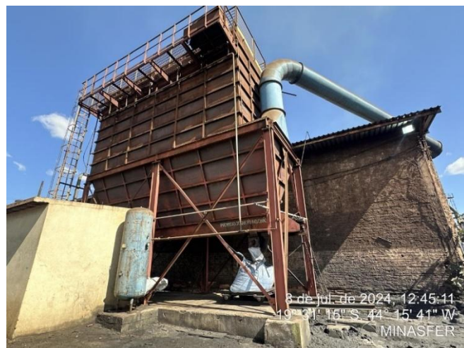
Foto 18: Filtro de mangas do peneiramento do minério
