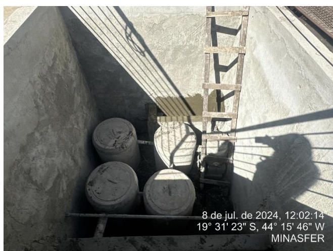
Foto 67: CSAO 02, associada ao lavador de veículos e seus respectivos compressores
