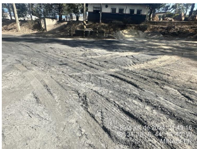
Foto 51: Vias não pavimentadas próximas ao tanque de pó de balão, possuindo resíduos de pó de balão na sua superfície
