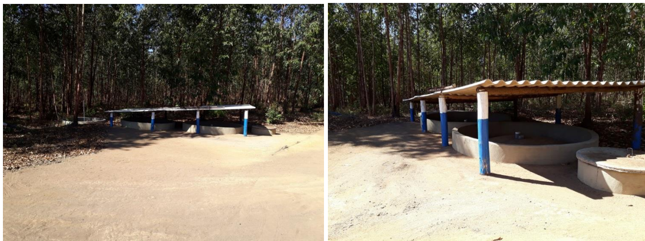
Fotos 7 e 8 – Sistema de tratamento de efluentes sanitários na área de apoio.
