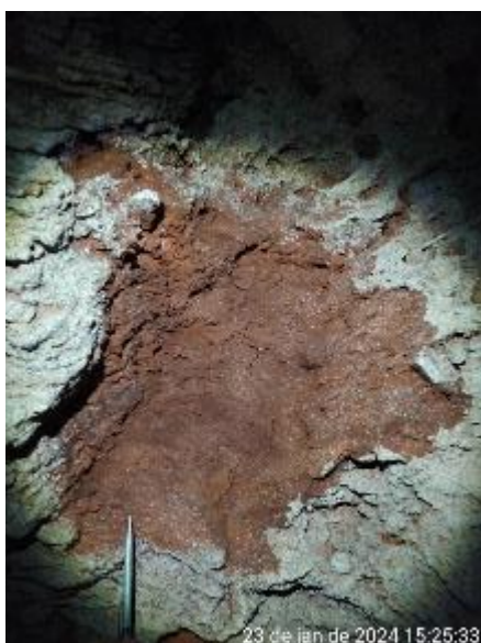
Foto 89 – Região de desagregação de material na parede contendo gretas de contração.
