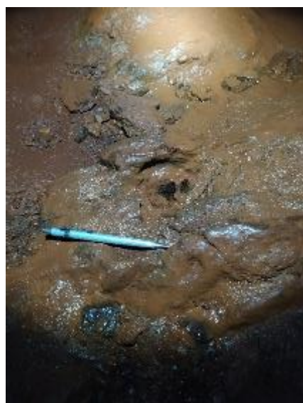
Foto 64 – Pontos de gotejamento e depósitos químicos.
