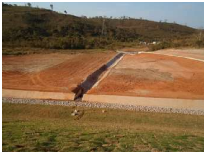
Estruturas de drenagem – dique 02
