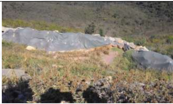
Medidas de contenção de sedimentos face oeste
