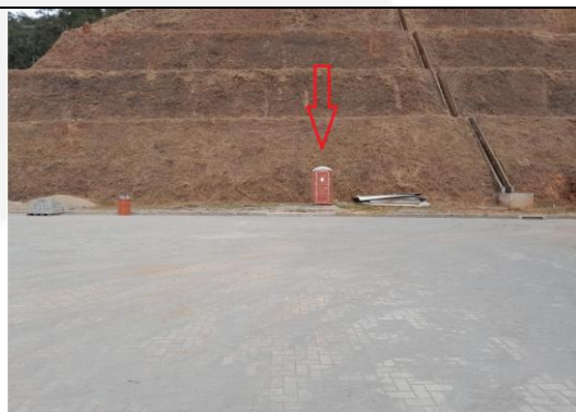
Figura 03: Banheiro químico (seta vermelha) instalado no empreendimento.
