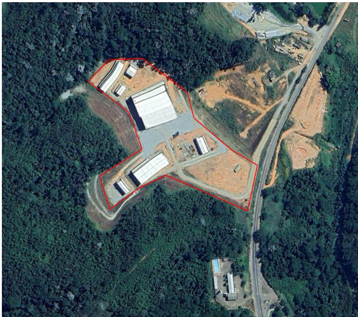
Figura 01: Área de instalação dos galpões. Polígono vermelho. Fonte: Caracterização do empreendimento no SLA.
