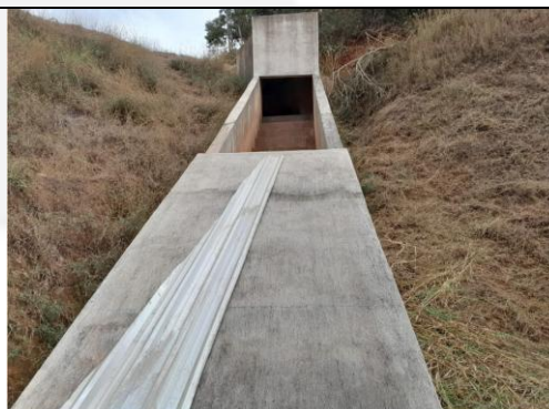
Figura 06: Escada dissipadora de energia do sistema de águas pluviais.
