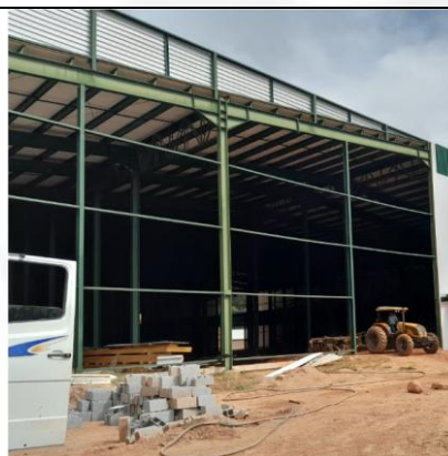
Figura 04: Galpão em obras.
