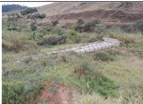
Figura 07: Instalação de tubulações em APP para condução dos efluentes líquidos tratados e águas pluviais até o curso d'água.
