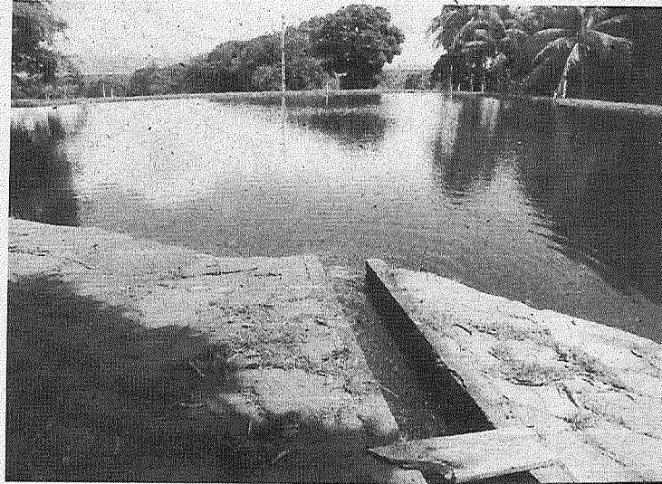
Imagem 04: Reservatório de água. Fonte: empreendedor.
