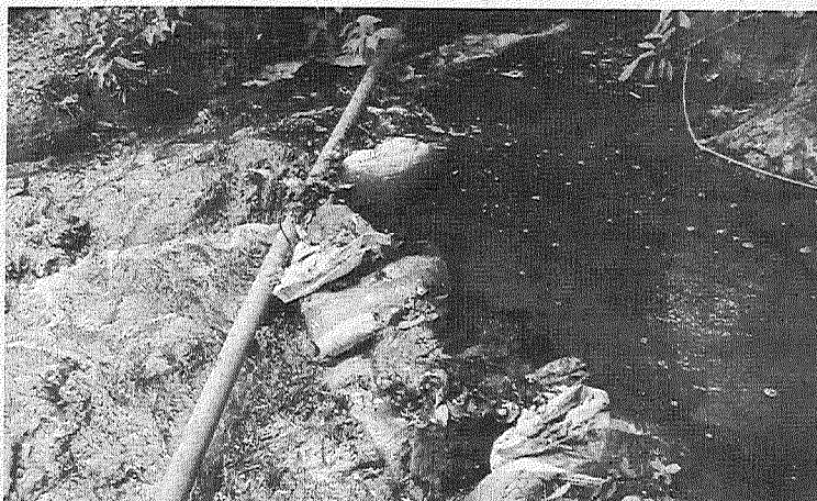
Imagem 02: Intervenção realizada no curso d'água. Fonte: empreendedor.
