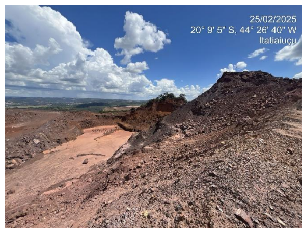
Foto 4. Fundo da cava da Área 46, evidenciando o acúmulo de finos proveniente do direcionamento da drenagem pluvial.
