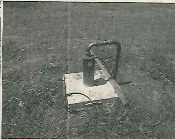
Figura 06. Poço (hidrômetro e horímetro anexos à caixa d'água)
