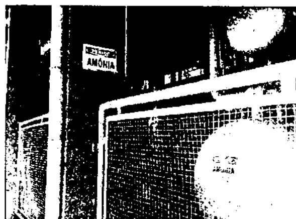
Foto 04: tanque de amônia; 23/12/2016.
