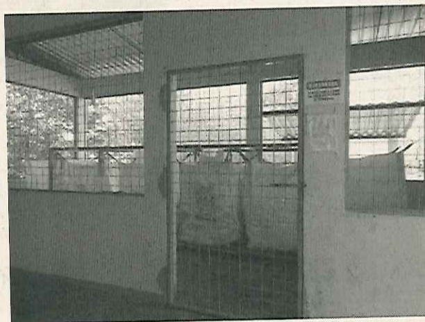
Foto 02. Central de resíduos sólidos
