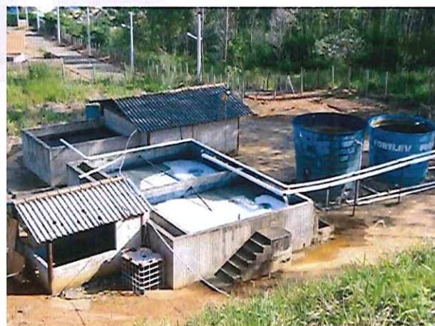
Foto 02. Estação de tratamento de efluentes Industriais
