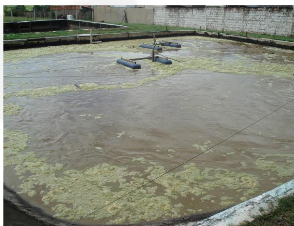
FOTO 04. Tanque de Aeração da ETE
