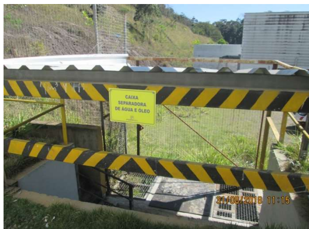
Caixa Separadora de Água e Óleo (SAO)
