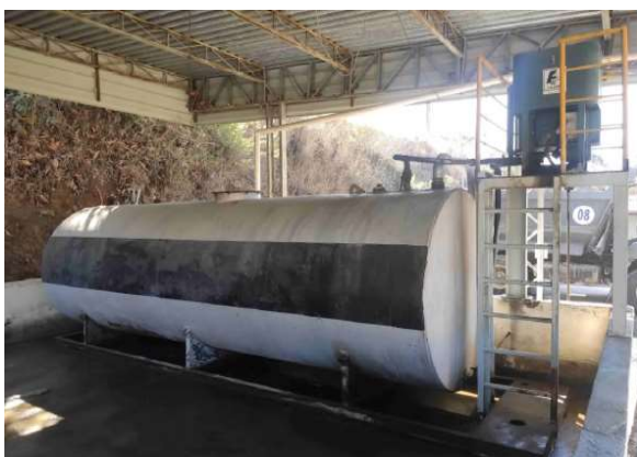
Interior da bacia de contenção (Fonte: RTS)
