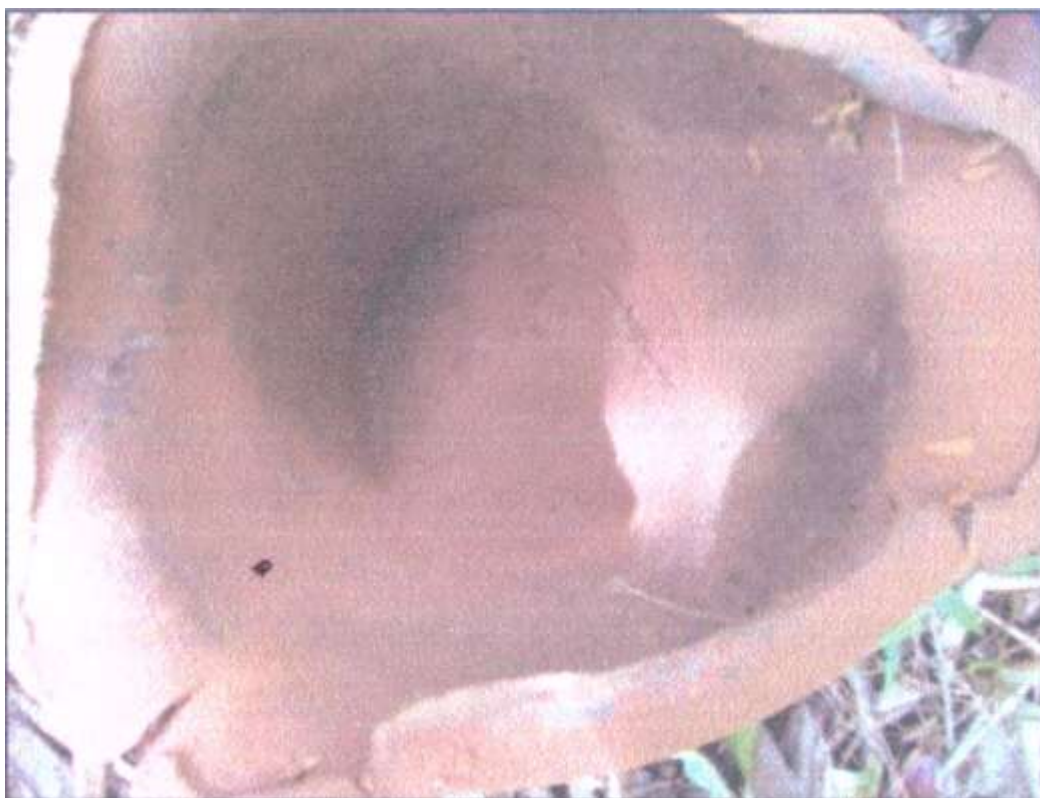
Imagem 8 – Vista interior do revestimento do poço entupido por terra.
