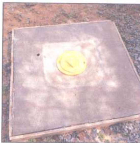
Imagem 9 – Laje de proteção no poço de monitoramento da área de fertirrigação.
