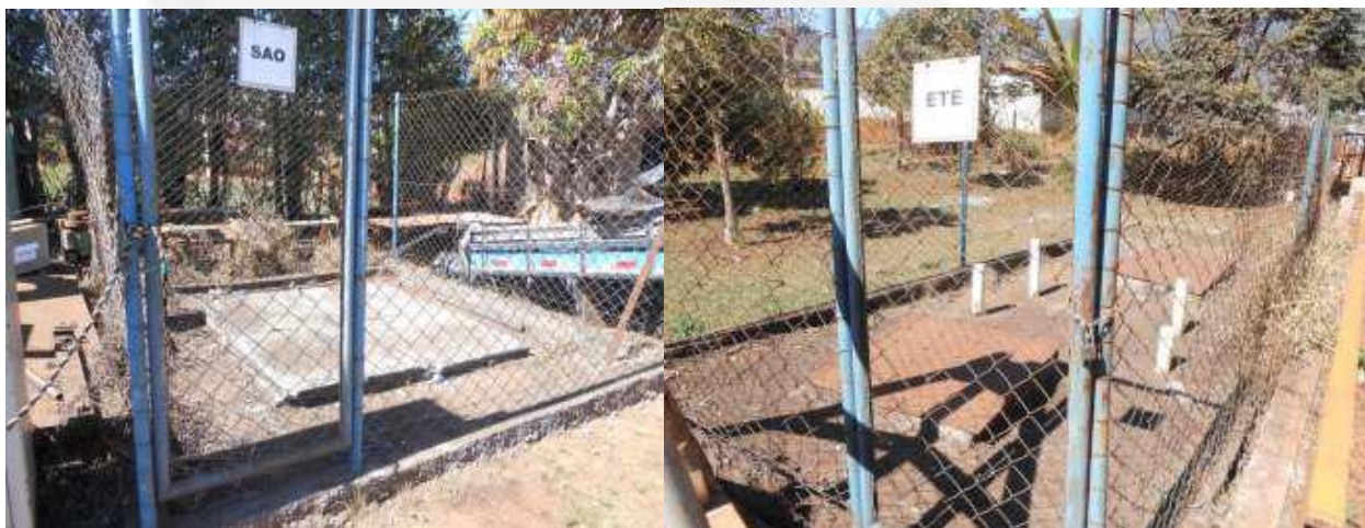
Figura 03: Sistemas de controle de efluentes industriais (separador água e óleo) e efluentes sanitários (fossa séptica)
