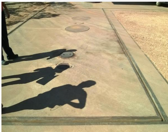
Foto 3- Canaletas de drenagem a redor da área de descarga.
