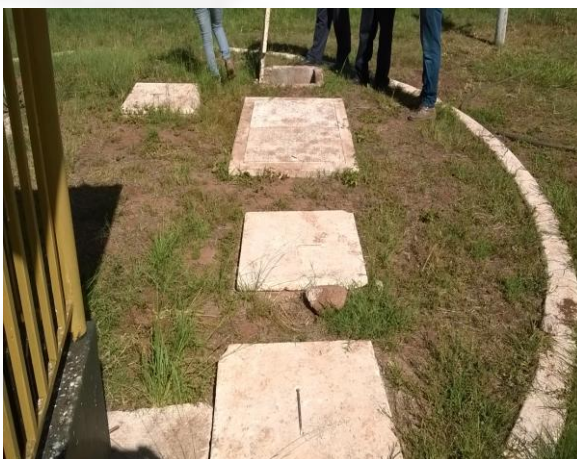
Foto 8- Caixa separadora de água e óleo.
