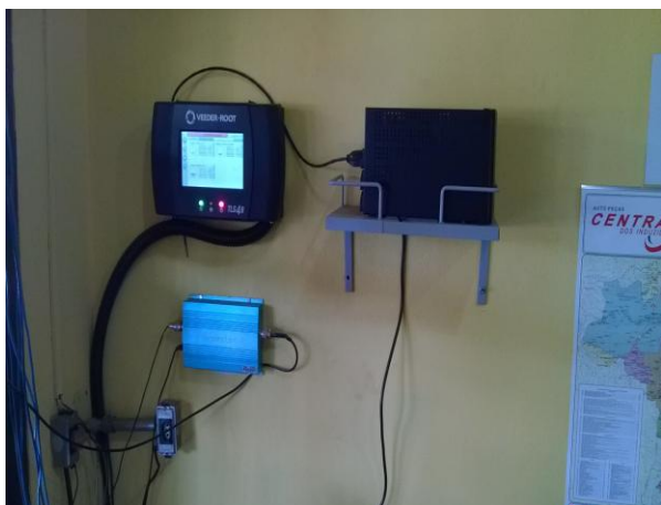
Foto 11- Painel do Veeder Root (monitoramento intersticial dos tanques).
